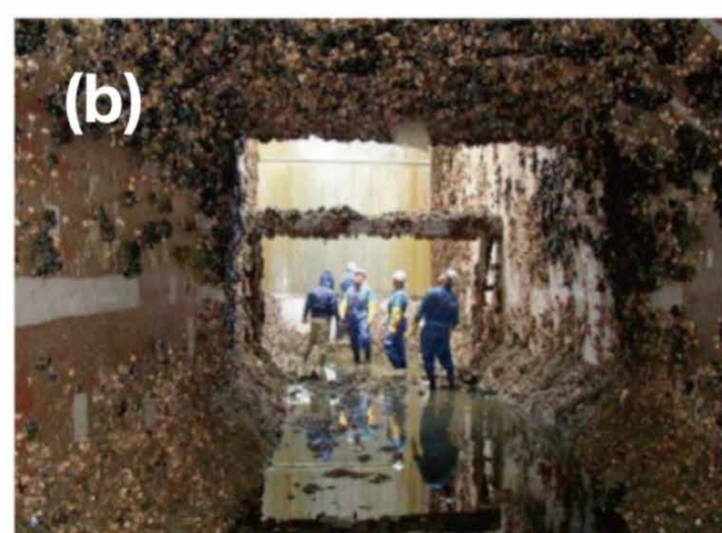
Fig.1 (a) フジツボ付着期幼生 (体長：約500 \mu m) と着生した成体 (直径：約15mm) (b) 発電施設の冷却水系統に付着したフジツボ群集
