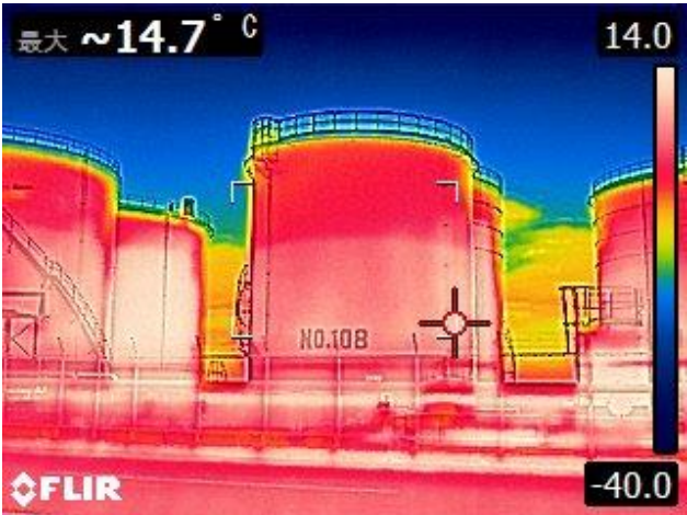
写真 1 石油タンク (10/27 昼間)
